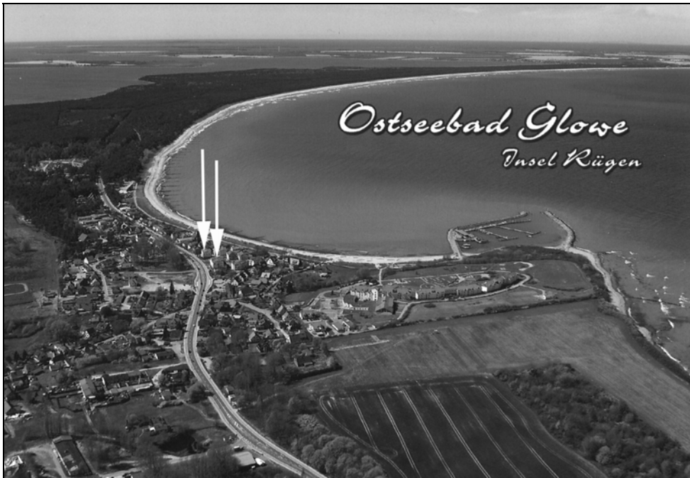
Abbildung 48: Schrägluftaufnahme auf einer aktuellen Postkarte (2007) des Seebades Glowe. Quelle: Ansichtskartenverlag Foto-Stavjinski
